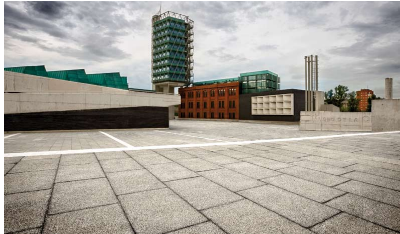
FOTO 5: Plaza sobre parking subterráneo en Plentzia, Vizcaya. Pavimento Granítico granallado gris de 60x40, combinadas con adoquín Numancia multipardo.
