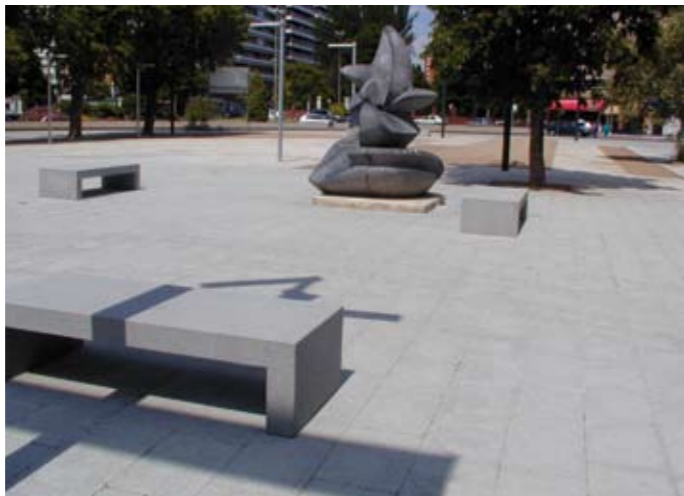
FOTO 1: Urbanización acera Recoletos. Valladolid. Pavimento Granítico granallado 60x40x6.
